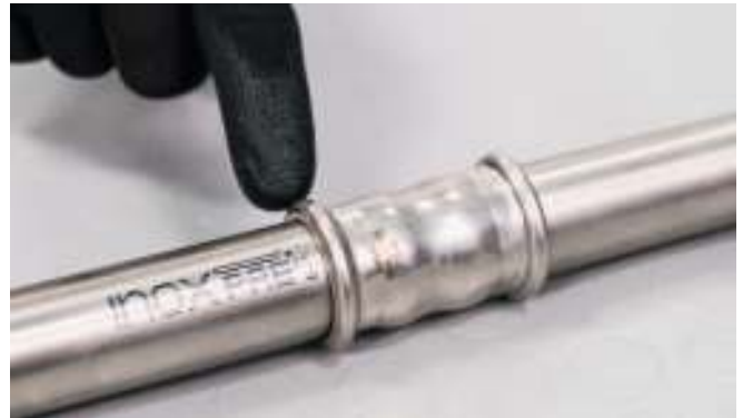
Рис. 33. Проверка пресс-соединения.
